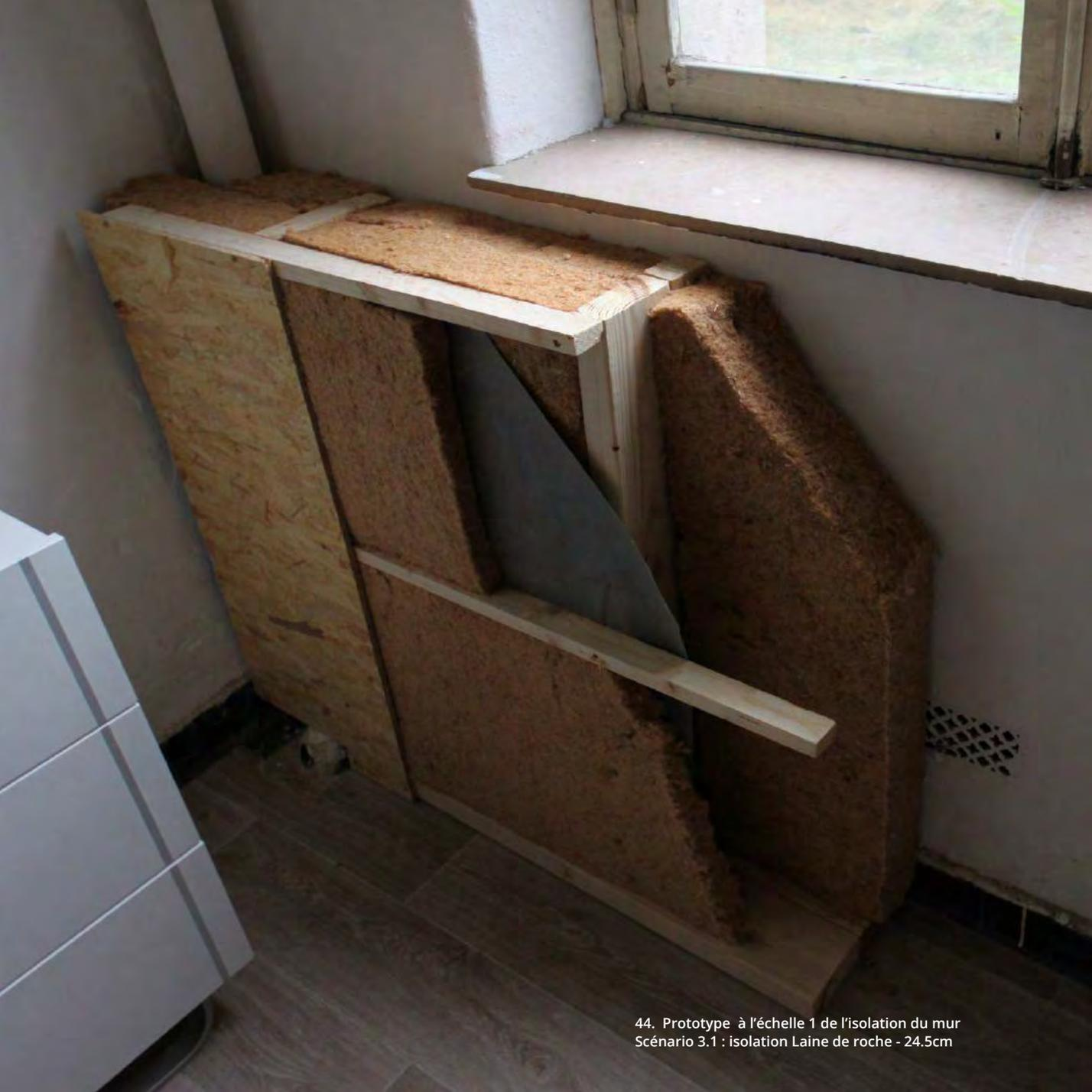
44. Prototype à l'échelle 1 de l'isolation du mur
