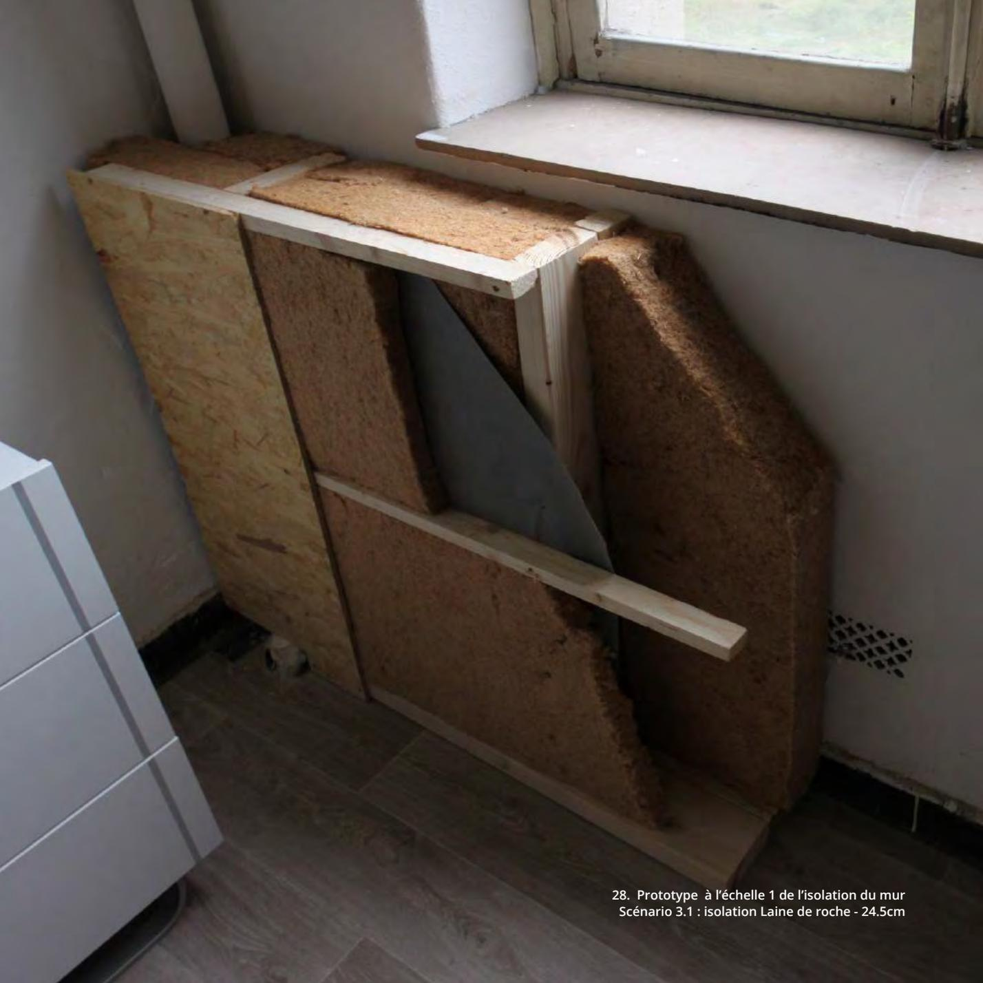
28. Prototype à l'échelle 1 de l'isolation du mur
