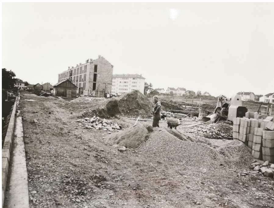
Figure 27 : AD 88, Fonds de la Reconstruction dans les Vosges, 1815 W 927, ANONYME, Golbey – Bâtiment collectif type NR, en cours de fondation, 16 octobre 1956.
