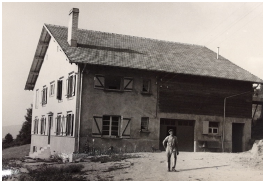
Figure 64 : AD 88, Fonds de la Reconstruction dans les Vosges, 1815 W 1836, ANONYME, Anould – Ferme avec exploitant, s.d.
