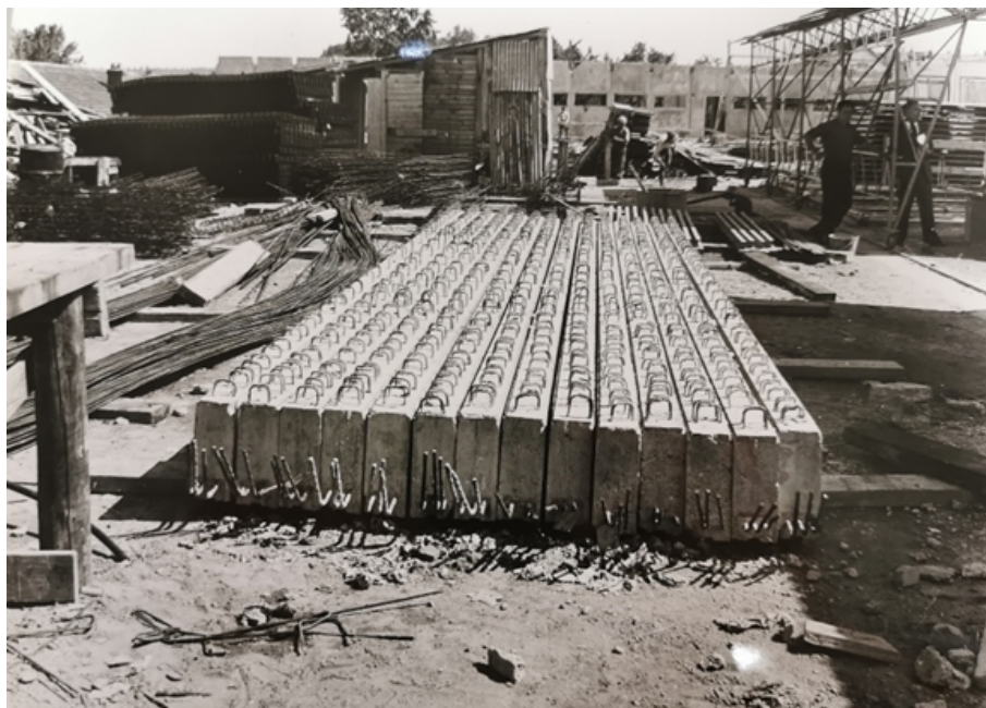
Figure 55 : AD 88, Fonds de la Reconstruction dans les Vosges, 1815 W 328, SERVICE DÉPARTEMENTAL DES PONTS ET CHAUSSÉES, Bruyères – Lycée, atelier de préfabrication, stock de poutres préfabriquées , 26 août 1964.
