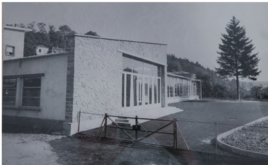
Figure 41 : AD 88, Fonds de la Reconstruction dans les Vosges, 1815 W 138, Anonyme, Saint-Dié – Groupe scolaire Thurin, septembre 1961.
