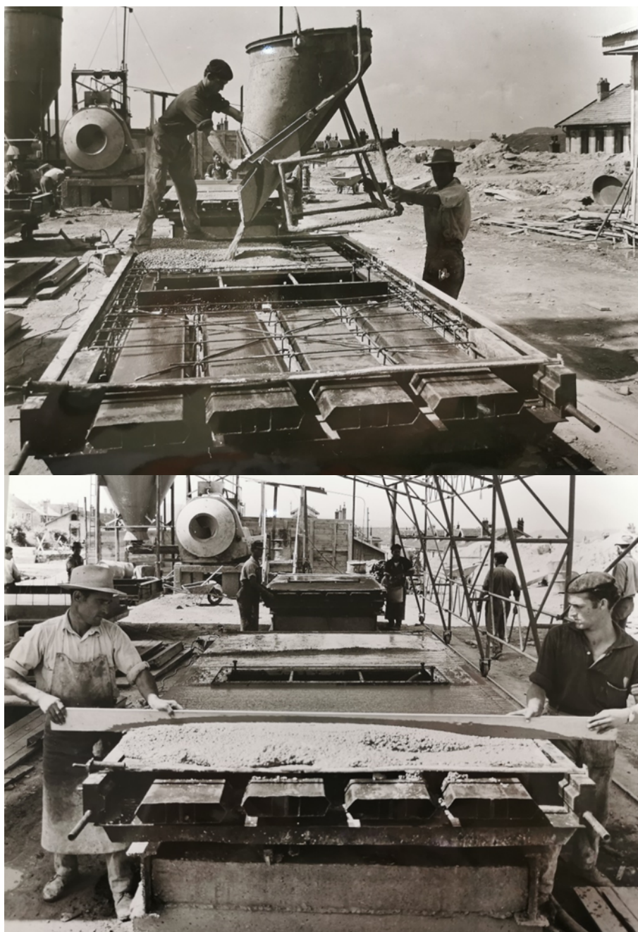
Figure 52 : AD 88, Fonds de la Reconstruction dans les Vosges, 1815 W 316, SERVICE DÉPARTEMENTAL DES PONTS ET CHAUSSÉES, Bruyères – Lycée, atelier de préfabrication , 26 août 1964.
