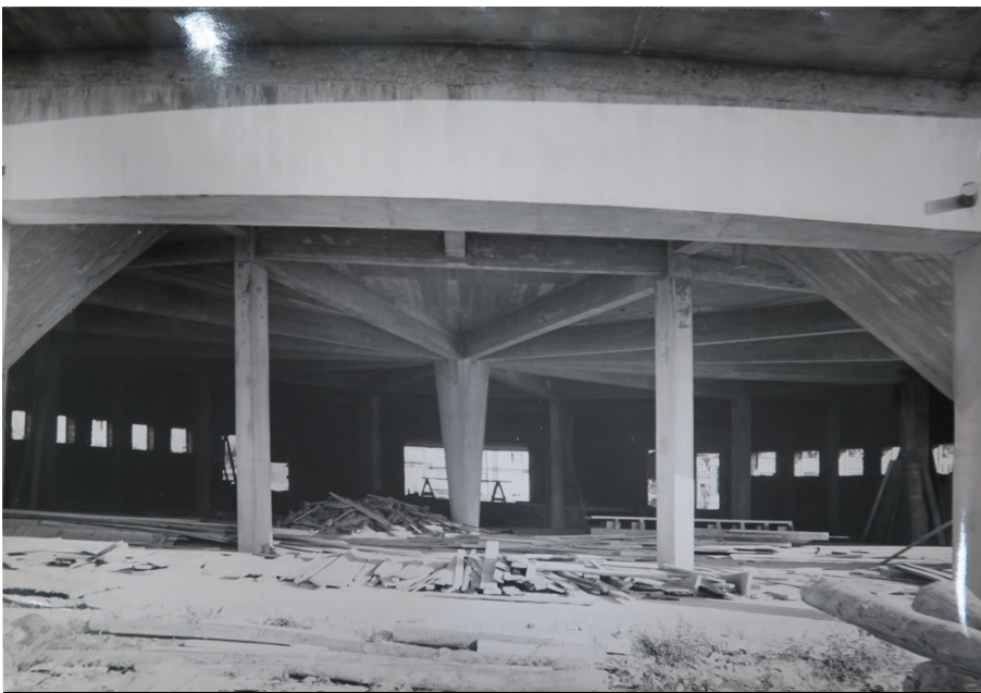
Figure 8 : AD 88, Fonds de la Reconstruction dans les Vosges, 1152 W 1010, ANONYME, Photographie du chantier de la salle communale de Saint-Dié, s.d.
