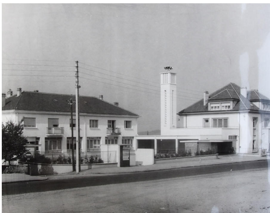
Figure 74 : Ibid. AD 88, Fonds de la Reconstruction dans les Vosges, 1815 W 1839, ANONYME, Anould – Papeteries du Souche, s.d.
