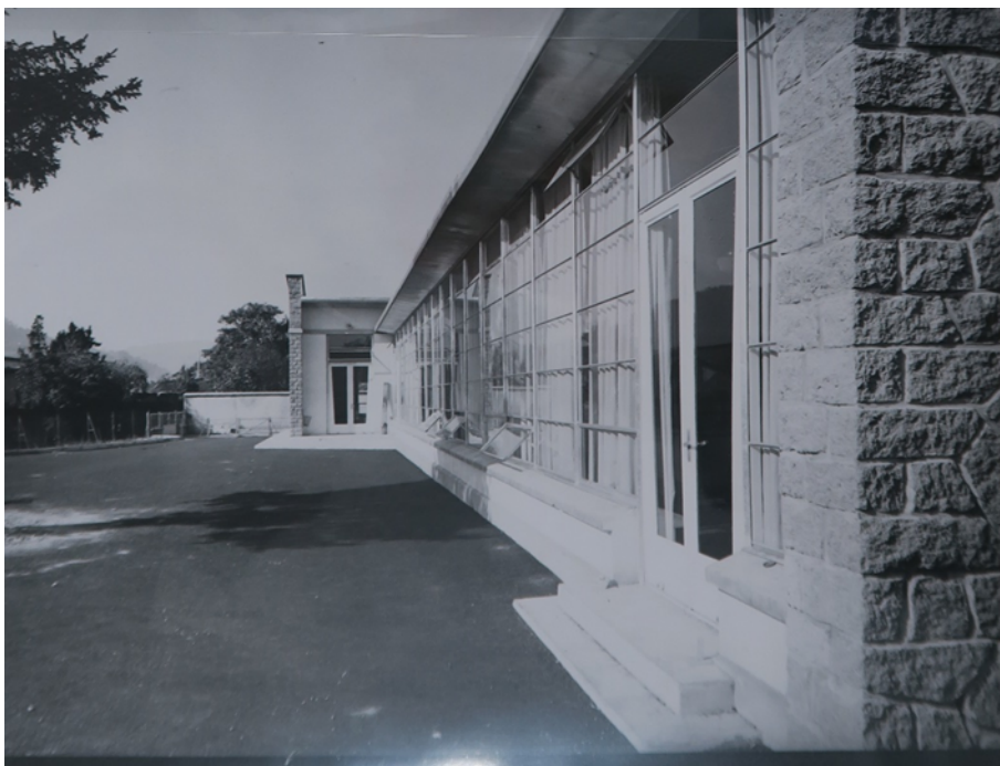
Figure 43 : AD 88, Fonds de la Reconstruction dans les Vosges, 1815 W 1302, ANONYME, Saint-Dié – Groupe scolaire d'Hellieule, maternelle, logement des instituteurs, juillet 1961.
