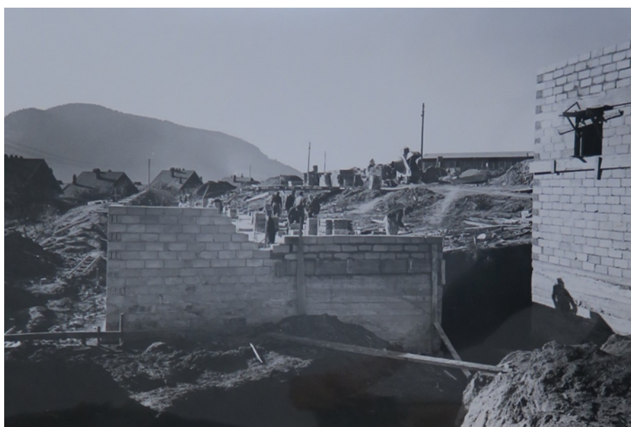
Figure 46 : AD 88, Fonds de la Reconstruction dans les Vosges, 1815 W 1390, DIRECTION DÉPARTEMENTALE DES VOSGES, Saint-Dié – Secteur industrialisé (Vosges), Office public départemental d'HLM. Batiment collectif D et E, 1 er juillet 1957.
