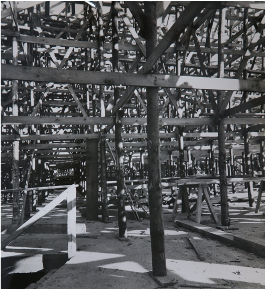
Figure 37 : AD 88, Fonds de la Reconstruction dans les Vosges, 1152 W 1010, ANONYME, Saint-Dié – Photographies de chantier, salle des fêtes, octobre 1962.
