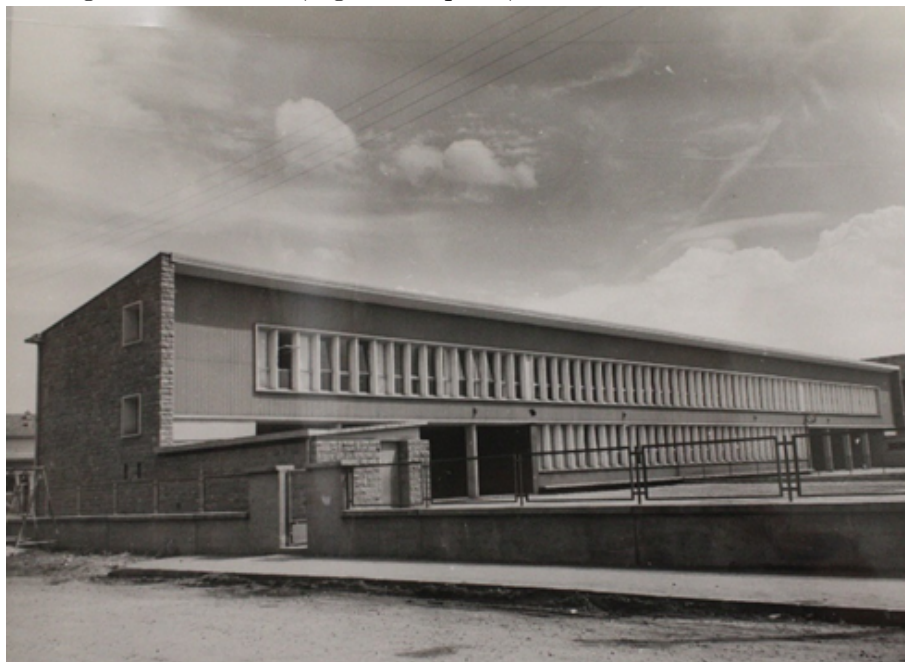
Figure 42 : AD 88, Fonds de la Reconstruction dans les Vosges, 1815 W 834, Anonyme, Saint-Dié – Groupe scolaire d'Hellieule, septembre 1961.
