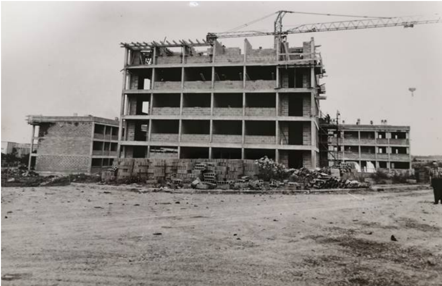
Figure 4 : AD 88, Fonds de la Reconstruction dans les Vosges, 1815W290-386, ANONYME, Contrexéville – Photographie de chantier du groupe d'habitations CILOF au Bois d'Hazau, août 1965.
