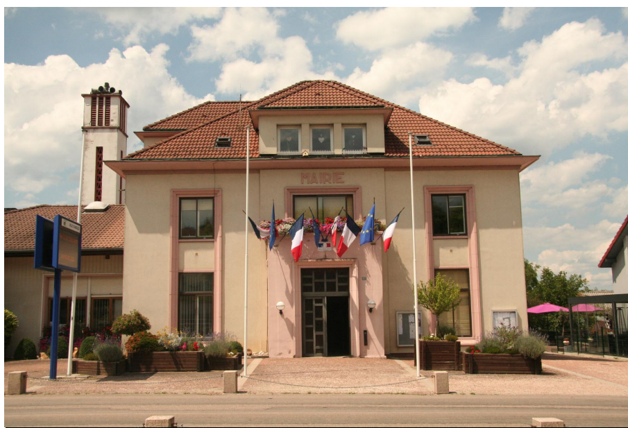
Figure 119 : Photographie Emma SCHWARB, Façade principale de la mairie d'Anould , 2018.
