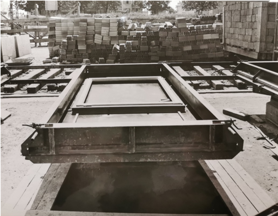
Figure 53 : AD 88, Fonds de la Reconstruction dans les Vosges, 1815 W 319, Service départemental des Ponts et Chaussées, Bruyères – Lycée, atelier de préfabrication, 26 août 1964.
