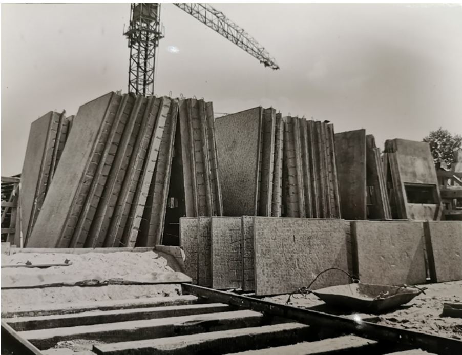
Figure 54 : AD 88, Fonds de la Reconstruction dans les Vosges, 1815 W 325, SERVICE DÉPARTEMENTAL DES PONTS ET CHAUSSÉES, Bruyères – Lycée, atelier de préfabrication, stock éléments de façade, 26 août 1964.
