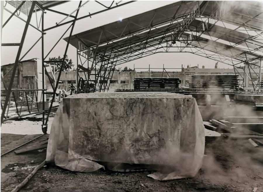
Figure 51 : AD 88, fonds de la Reconstruction dans les Vosges, 1815 W 313, SERVICE DÉPARTEMENTAL DES PONTS ET CHAUSSÉES, Bruyères – Lycée, atelier de préfabrication , 26 août 1964.
