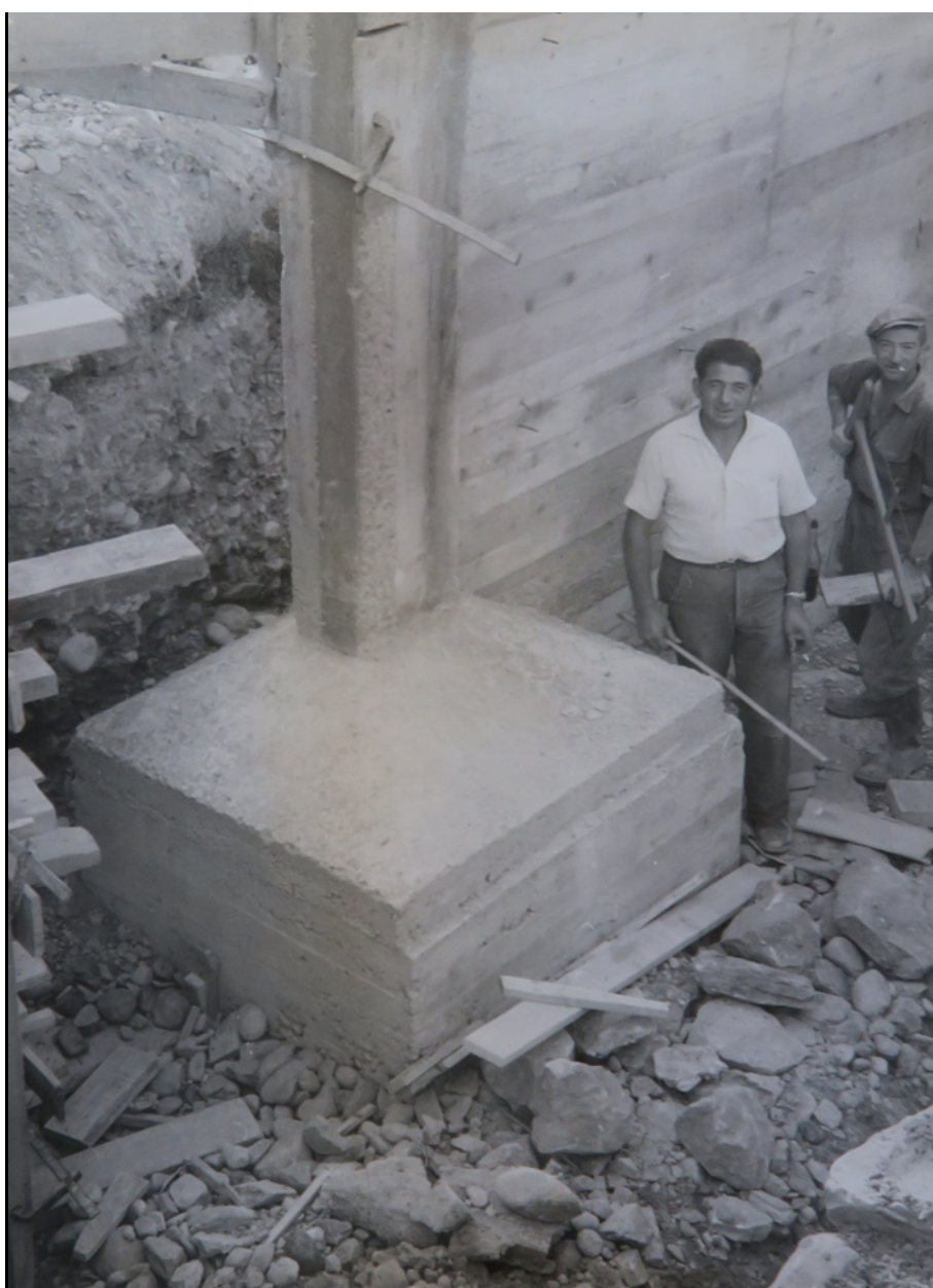
Figure 35 : AD 88, Fonds de la Reconstruction dans les Vosges, 1152 W 1010, ANONYME, Saint-Dié – Photographies de chantier, salle des fêtes, 1 er septembre 1961.
