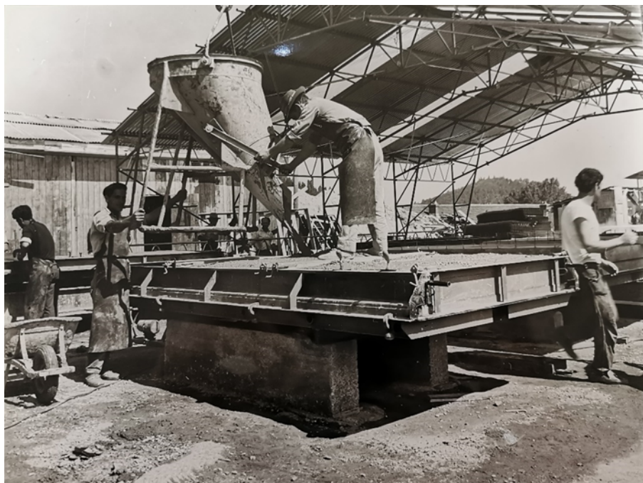
Figure 50 : AD 88, Fonds de la Reconstruction dans les Vosges, 1815 W 313, SERVICE DÉPARTEMENTAL DES PONTS ET CHAUSSÉES, Bruyères – Lycée, atelier de préfabrication , 26 août 1964.
