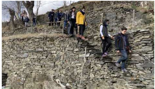
Escaliers traditionnels construits dans la continuité du mur de soutènement.
