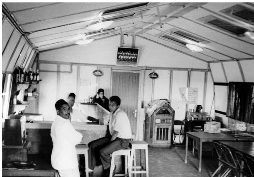
Fig. 2 - Vue intérieure d'un hangar à parois inclinées Fillod, Algérie. Collection privée. D.R.
