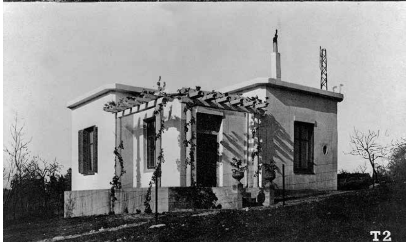
Fig. 2 - Prototype de la maison «tout acier» (décliné en deux états successifs), à Saint-Amour. Photographie, s.n. (collection particulière). Publiée dans un catalogue de la C.M.F. ; Les maisons des Constructions Métalliques Fillod , Paris, Ed. Paul-Martial, s.d. [années 1930]. Cliché Jérôme Mongreville © Région Bourgogne-Franche-Comté, Inventaire et Patrimoine ; ADAGP, 1994
