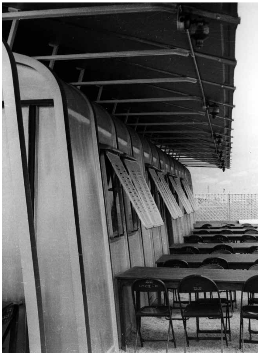
Fig. 3 - Vue extérieure d'un hangar à parois inclinées, montrant le système de parasol, Algérie. Collection privée. D.R.
