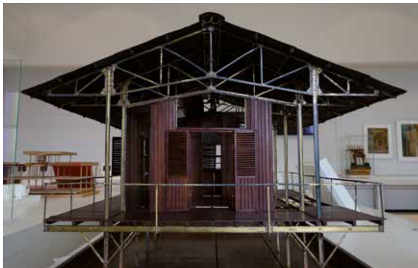
Fig. 1 - Maison démontable en fer pour Colonies. Moreau frères. Ca. 1890. Musée des arts et métiers. inv. 12002. Photo O. Delarozière
