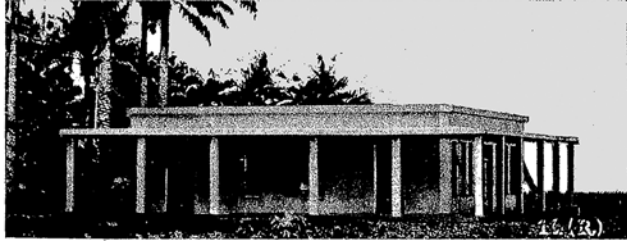
Fig. 1 - Photographie d'une maison Fillod, variante « coloniale ». Le modèle de base (premier type établi en 1928) est entouré d'une véranda. Image et texte parus dans l'article du Colonel Icse, « La maison métallique coloniale », Urbanisme, revue mensuelle de l'urbanisme français , n° 36 (4 e année), mai 1935, p. 223.
