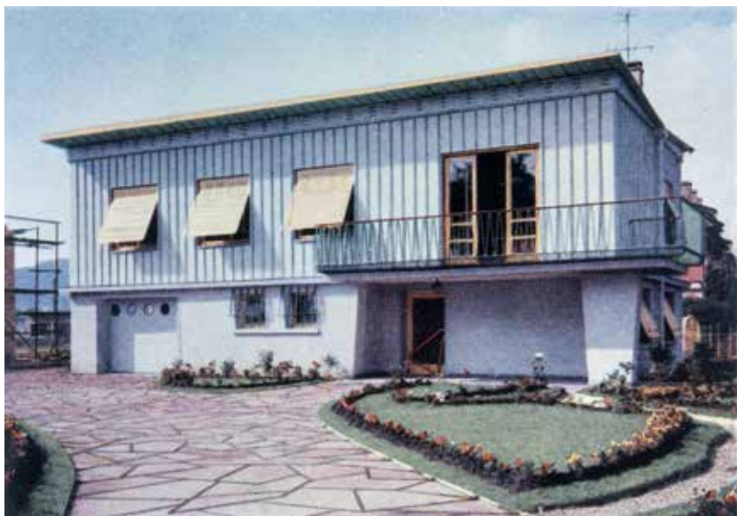
Fig. 4 - Bâtiment à parois verticales normales, non localisé. Photographie, s.n. (collection particulière). Publiée dans un catalogue de la C.M.F. : Fillod solution rapide et définitive de tous problèmes de construction , Paris, Ed. Paul-Martial, s.d. [1959]. Cliché Jérôme Mongreville © Région Bourgogne-Franche-Comté, Inventaire et Patrimoine ; ADAGP, 1990
