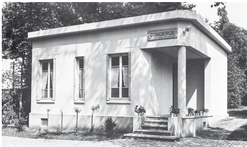
Ill.2 : ensemble de construction mécanique de la Manufacture de Tôlerie F. Fillod FSA : exemple de construction : maison T4 à usage de conciergerie. Photographie, s.d. [1ère moitié 20e siècle, années 1930]. Photographie également publiée dans : Les maisons des Constructions Métalliques Fillod / [Constructions Métalliques Fillod S.A.], Paris : Ed. Paul-Martial, s.d. [années 1930], [p. 10]. Collection particulière - Reproduction Yves Sancey © Région Bourgogne-Franche-Comté, Inventaire et Patrimoine, ADAGP, 1994
