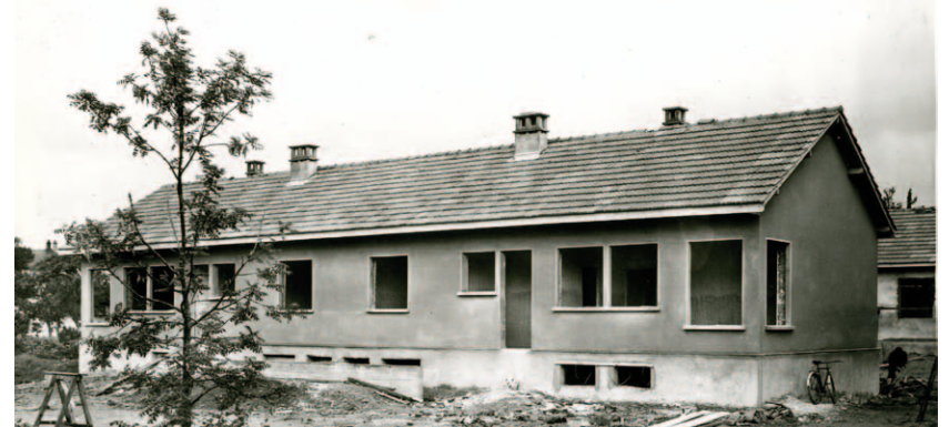
Ill. 5 : prototype construit par l'entreprise Sartore et les architectes Dupupet et Escande, 1949. Archives Municipales de Metz, 104 W1, droits réservés.
