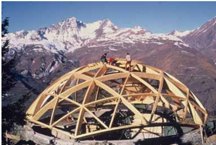
Auditorium de Bourg Saint Maurice. Dôme géodésique en bois lamellé collé / Réalisation 1966
