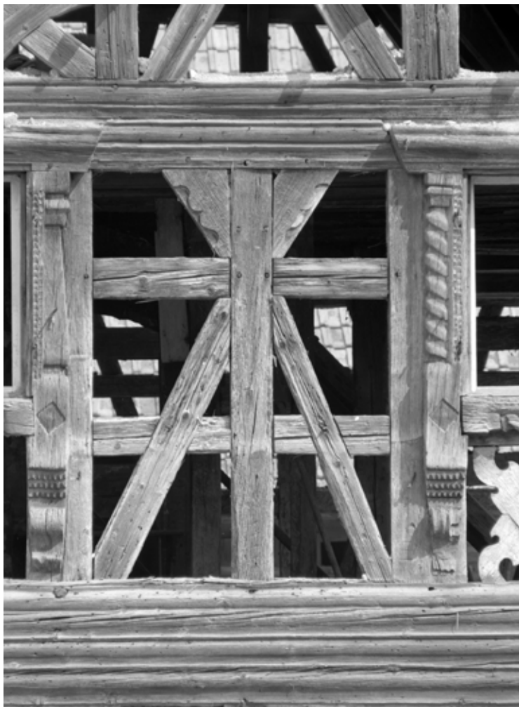
Détail du pan-de-bois au premier étage de la façade sur rue du logis daté 1623 de la ferme n°3 rue Principale à Uttenheim dans le Bas-Rhin (Région Grand Est - Inventaire général © Cl. Menninger
