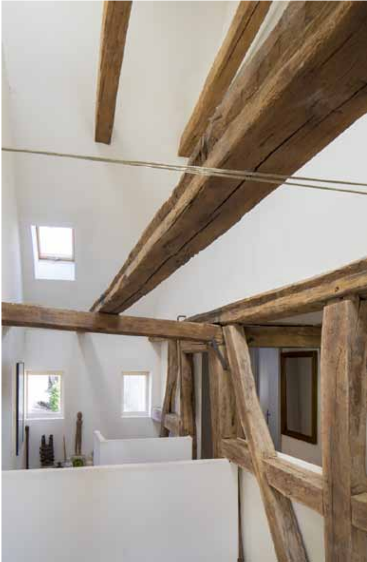
Ancienne ferme du XVII e siècle. Création d'un logement pour les propriétaires dans l'ancien logis et aménagement de leurs lieux de travail dans les dépendances. UBIQ Architectes - Anne Bechtold architecte DPLG - Jean-Guy Bourhis architecte DENSAIS
