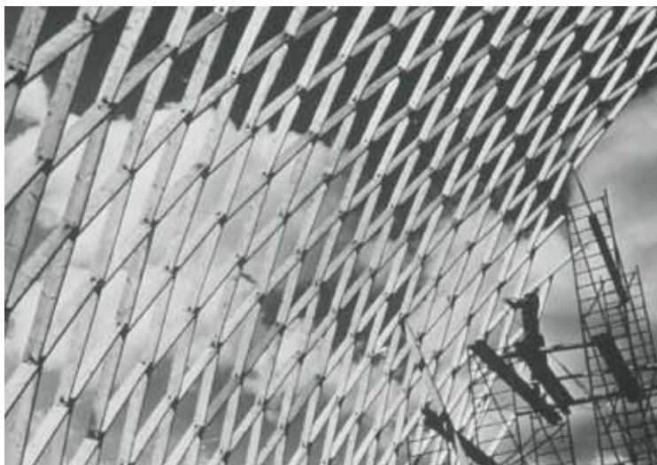
Église de Viroflay, Résille losangée Zollinger / Réalisation 1967
