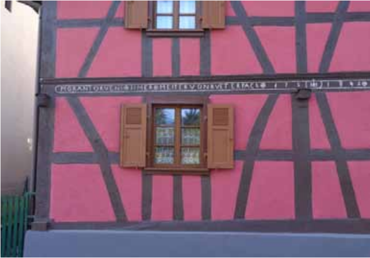
Hirtzbach (68), détail d'une maison due au charpentier Morand Kueny de Ruederbach (MORANT KUENI ZIMMERMEITER VON RUETERBACH°, datée de 1784.
