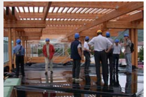
Assistance à la coordination de chantier Collège Blénod les Pont-à-Mousson Architectes : MJ CANONICA, A. CARTIGNÈS
