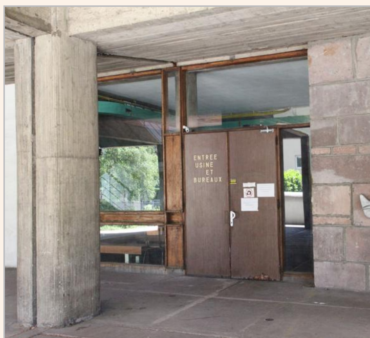
Un des principes de la construction de l'usine : des pilotis sur lesquels s'accrochent tous les niveaux sans mur porteur. Photo Victor SALVADOR
