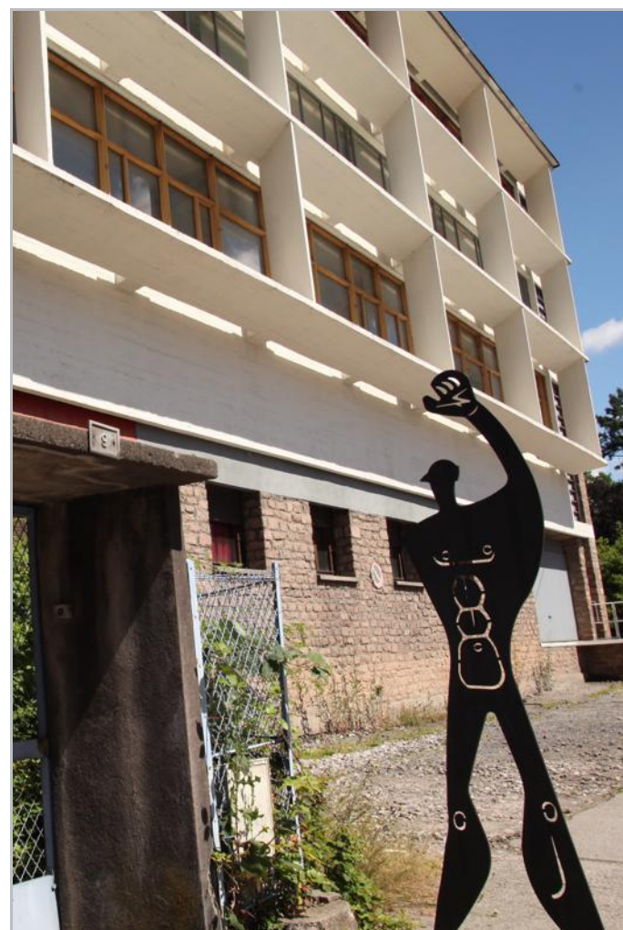
La seule usine construite par Le Corbusier.
