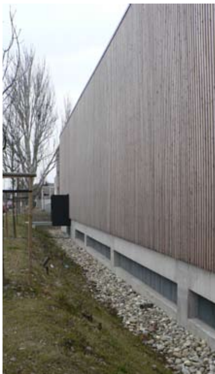
Une écriture architecturale contemporaine pour le silo à voitures
