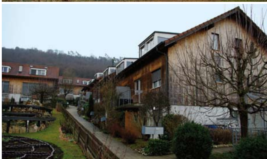
Intégration à la pente, matériaux locaux, minimisation de l'impact des véhicules, autopromotion : une leçon de développement durable
