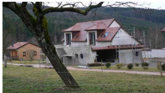
Lotissement en contruction à St Gangolphe.
