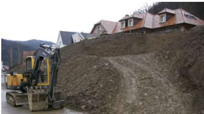
Les coteaux en chantier.
