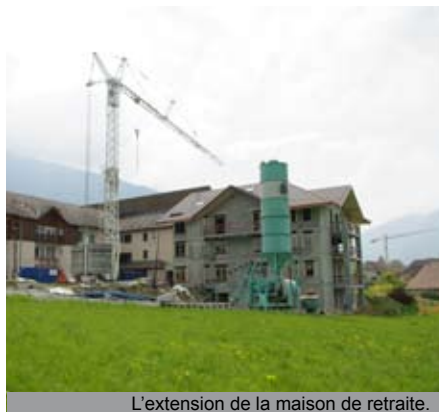
L'extension de la maison de retraite.
